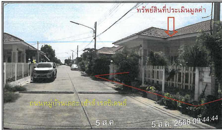
สภาพถนนหมู่บ้านเดอะ เฮ้าส์ เรสซิเดนซ์ บริเวณผ่านหน้าที่ตั้งทรัพย์สินที่ประเมินมูลค่า (จุดถ่ายภาพที่ 4)
