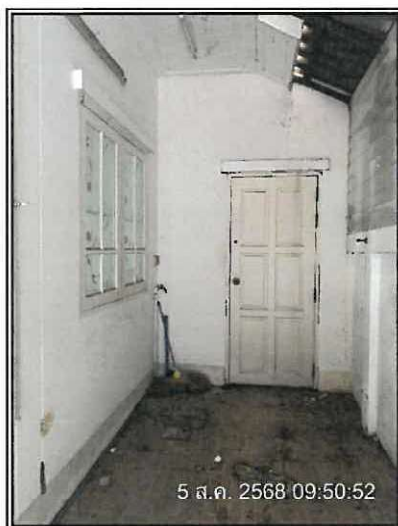
สภาพภายในอาคาร บริเวณซักรีด
